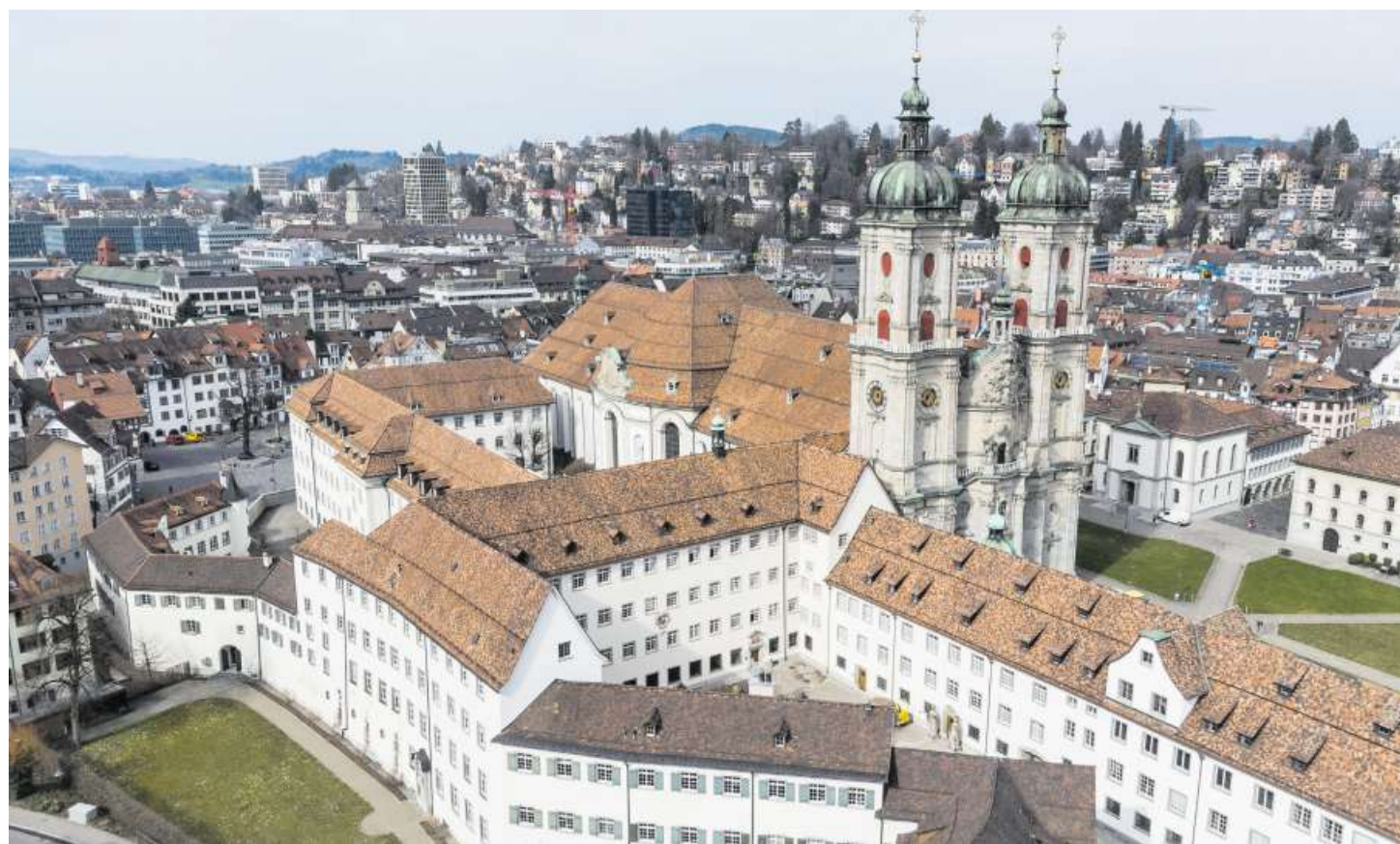
Blick auf das Stiftsgebäude: Im Vordergrund, mit dem etwas dunkleren Dach, der Klosterhof 8a. Der Mittelbau ist der Pfarr- und Verwaltungsflügel. Der Dekanatsflügel ist erkennbar am kleinen Glockenturm. Links im Bild ist der geknickte Türmli-Flügel zu sehen. Bild: Ralph Ribl
